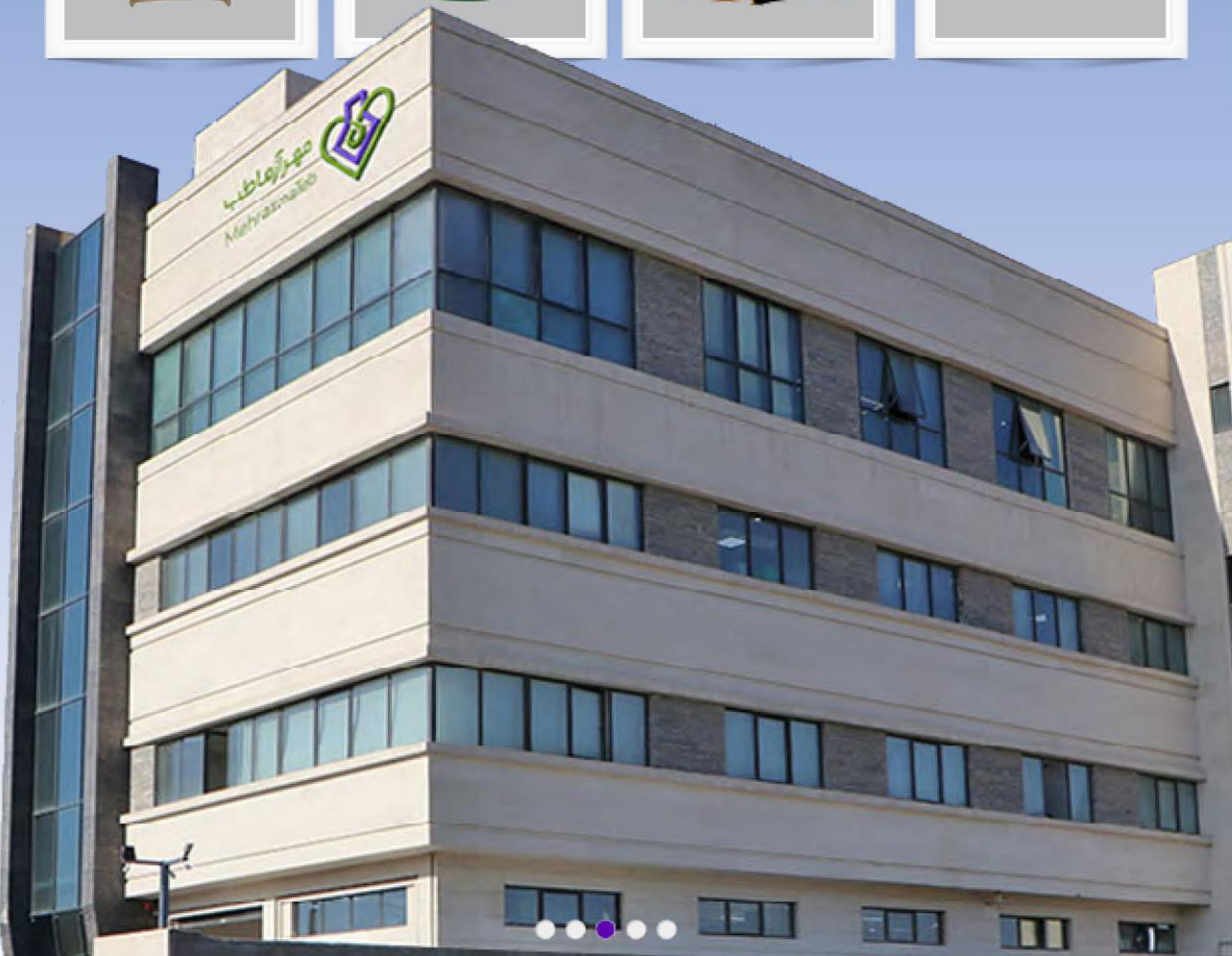
ساختمان مرکزی مهرآزما / شعبه مرکزی
